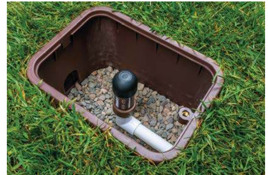
Entlüftungs-/Druckausgleichsventil installiert
