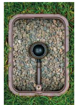
Automatisches Spülventil installiert
