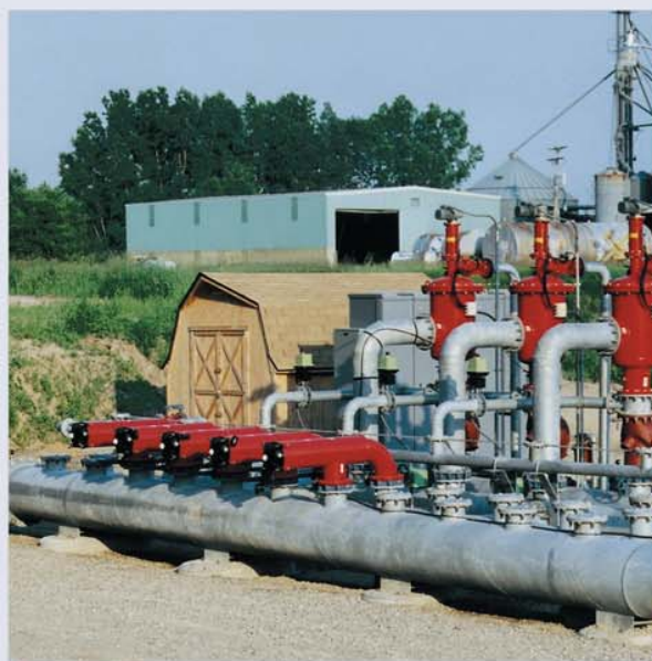
▲ Prefiltrazione, controllo del mitilo zebrato. Mud-Creek, USA
