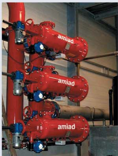
▲ Pré filtration eau de process, 600m 3 /h, 200µm. Acierie. France
