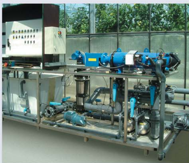
▲ Pré filtration UV, 90m 3 /h, 25µm. Serres, Hollande
