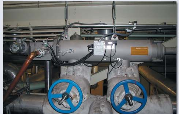
▲ Process peintures, 45m 3 /h, 10µm. Avionneur. Seattle, USA
