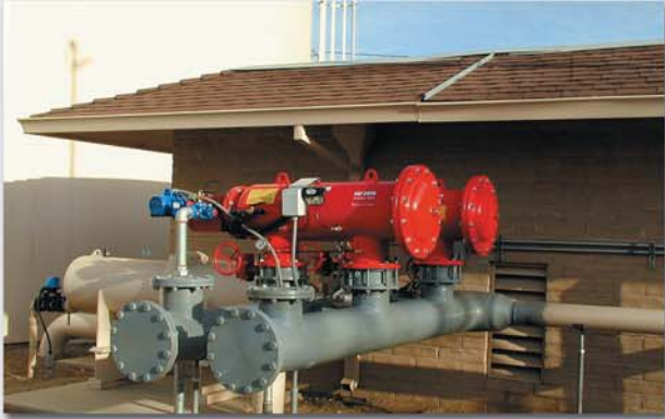
▲ Fourniture eau potable, 300m 3 /h, 200µm. Ville de Modesto, Californie USA
