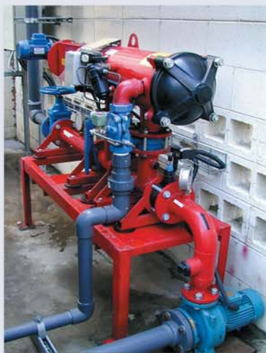
▲ Tour de refroidissement, 10m 3 /h, 25µm. Aéroport LAX Los Angeles, CA. USA
