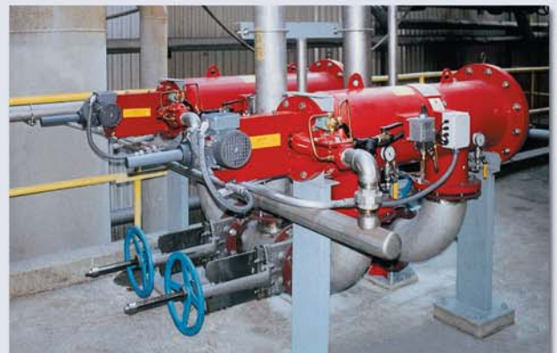
▲ Eau de process, 200m 3 /h, 25µm. Papeterie. Washington, USA
