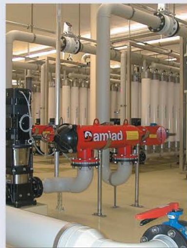
▲ Pré filtration de membranes UF, 500m 3 /h, 130µm. Conthey, Suisse
