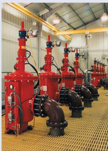
▲ Aquaculture – Contrôle des moules Zébra. 2 000m 3 /h, 25 microns. Vermont, USA
