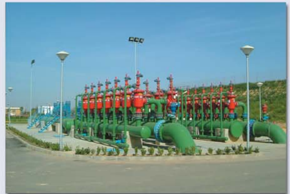
▲ Irrigation goutte à goutte, Fraisières. 14 000m 3 /h, 130 microns. Espagne
