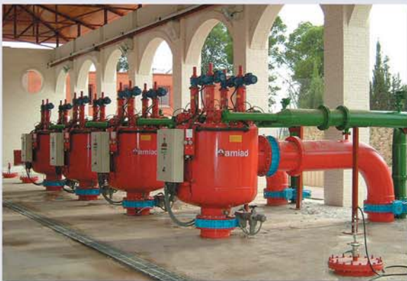
▲ Irrigation goutte à goutte. 8 000m 3 /h, 130 microns. Helche Creviente, Espagne
