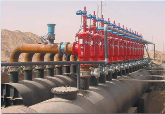
▲ Irrigation goutte à goutte. 9 000 m 3 /h, 130 microns. Chine
