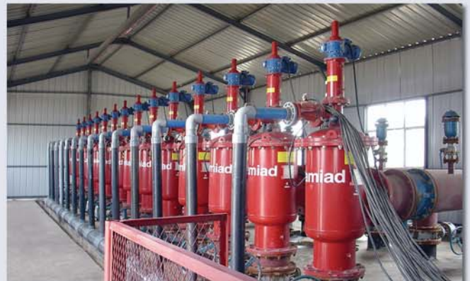
▲ Armée chinoise ; Irrigation de la 14ème division ; 14 000 m 3 , 130 microns. Xinjiang, Chine
