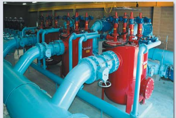
▲ Fourniture d'eau pour d'irrigation et une zone récréative. 3 400 m 3 /h, 80 microns. Spanish Fork, USA
