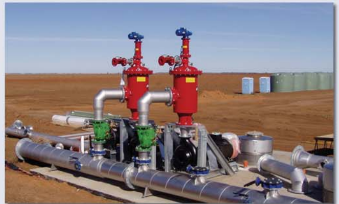
▲ Irrigation goutte à goutte amandiers, 3 950m 3 /h, 130 microns, Eau de rivière. Fermes Lachlan, Australie
