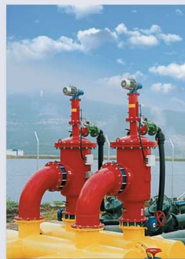
▲ Réservoir irrigation. 1 000m 3 /h, 100 microns. Kfar Hasidim, Israël
