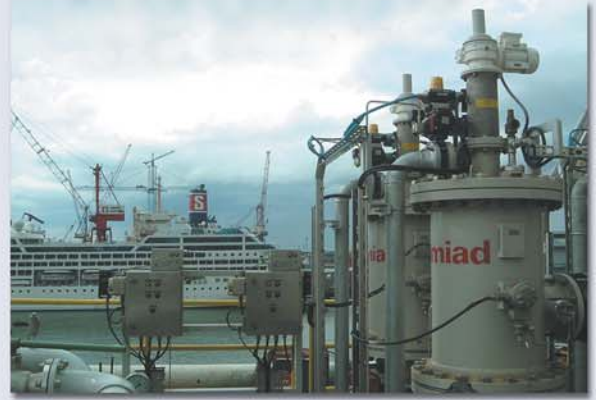
▲ Eau d'injection à bord d'un FPSO. 220m 3 /h, 25 microns. Afrique de l'Ouest
