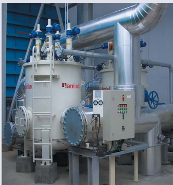
▲ Eaux usées industrielles. 800m 3 /h, 50 microns. Industrie électronique, Corée
