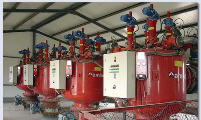
▲ Armée chinoise Projet d'irrigation. 16 000m 3 /h, 130 microns. Xinjiang, Chine
